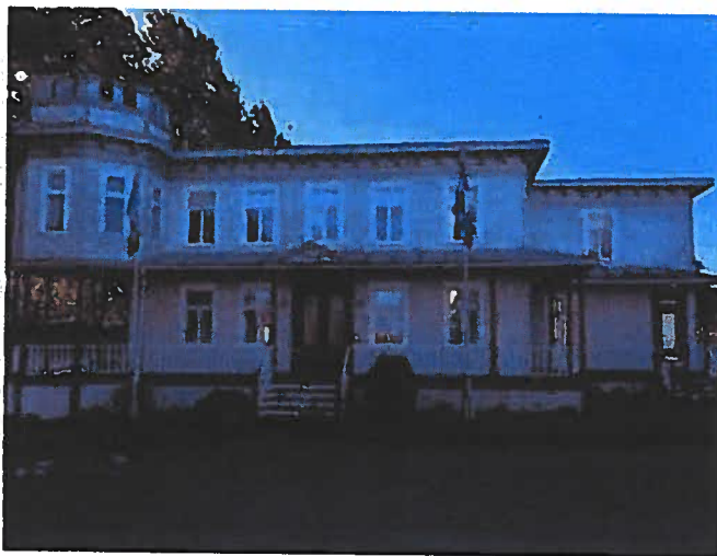
Figure 2 : Façade avant nord.
